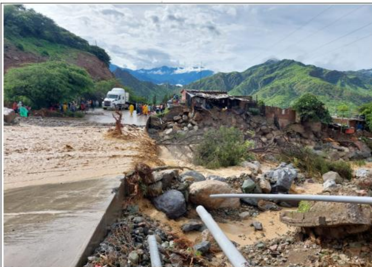
FIGURA N° 01: Colmatación del cauce de la quebrada con vegetación, rocas y sedimentos.
