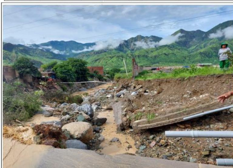
FIGURA N° 03: Derrumbes en los márgenes de la quebrada por la acción hídrica, así como también colmatación de vegetación, arenas, rocas y sedimentos.
