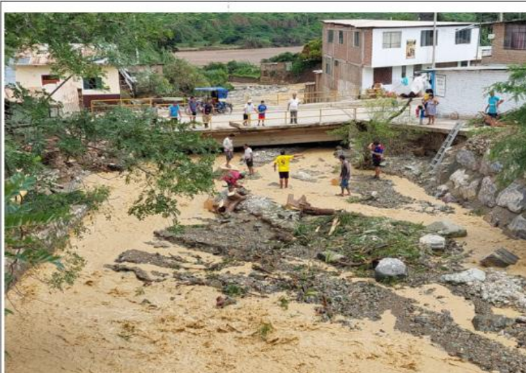
FIGURA N° 02: Colmatación de arenas, gravas y sedimentos a lo largo del cauce de la quebrada, se puede observar que la colmatación ya llega a la losa del puente.
