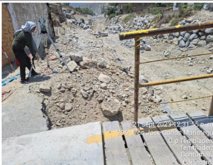
FIGURA N° 05: Erosión del suelo debido a la acción Hídrica , afectando el margen Izquierdo de la quebrada, quedando éste tramo sin veredas.
