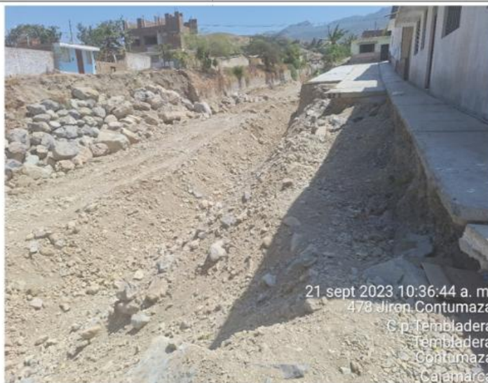
FIGURA N° 06: Debido a la agresiva crecida de la quebrada se ha producido deslizamientos en el margen Izquierdo dejando a este tramo sin calle.
