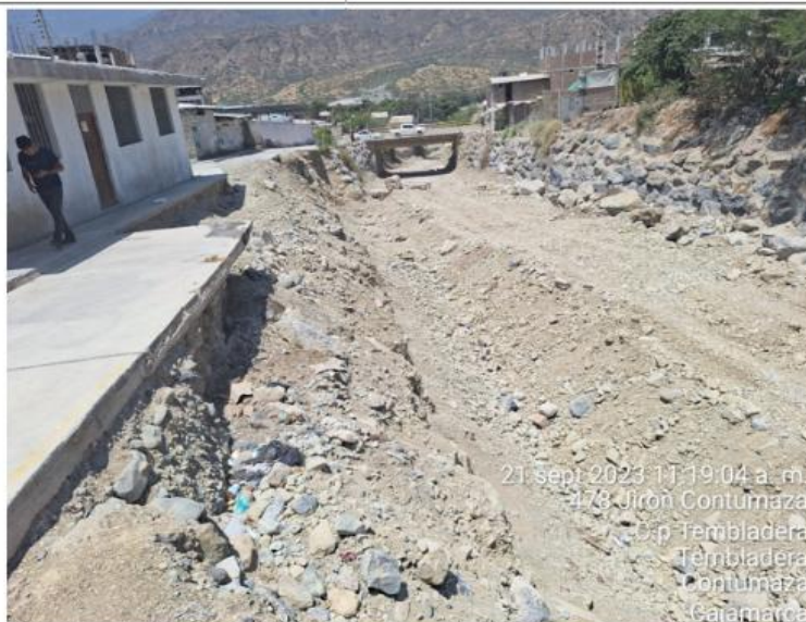
FIGURA N° 07: Debido a la agresiva crecida de la quebrada deslizamientos de el margen izquierdo, se puede observar que la losa de concreto de la vía se encuentra expuesta y a punto de colapsar.
